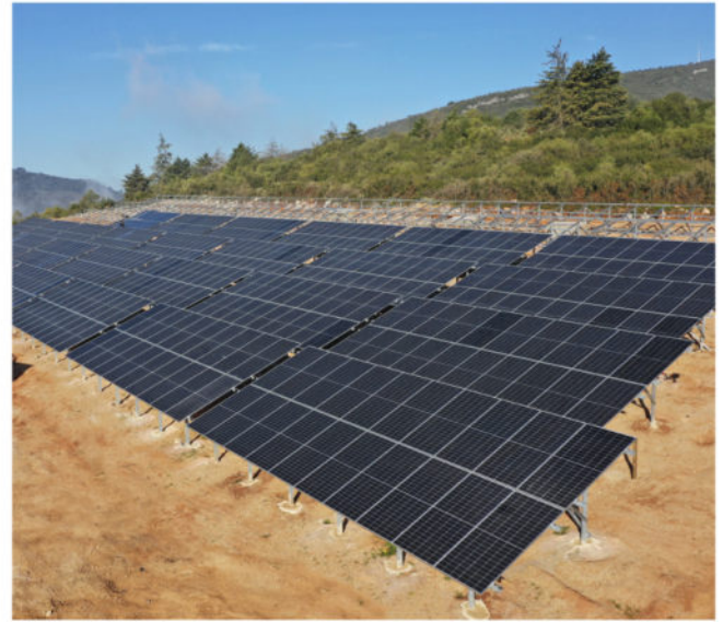
Parque Solar - Windpark, Lda. | Penela, Portugal Obra em curso
