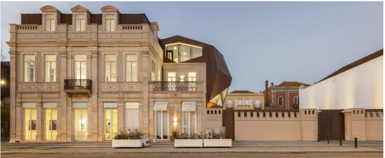
Edificio Henrique Mariano | Figueira da Foz
