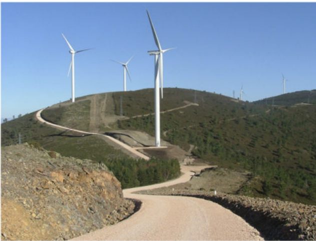
Parque Eólico da Lousã | Lousã, Portugal
